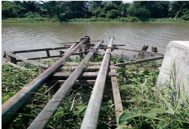
Gambar 3.10 Sungai Martapura dan Intake IKK Sungai Tabuk
