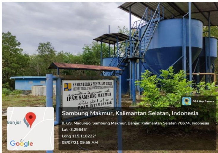
Gambar 3.26 IPA Sambung Makmur Cabang III Kap. 20 L/detik
