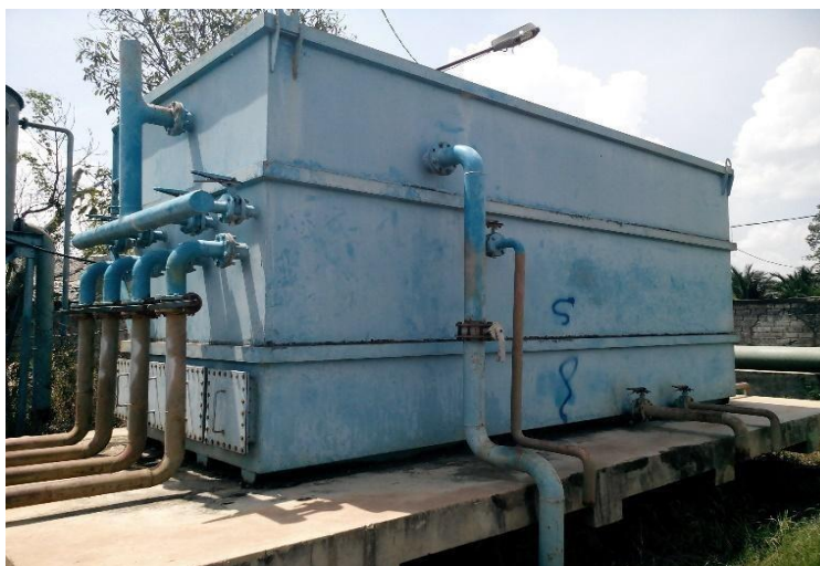
Gambar 3.16 IPA II Maswandi dengan kapasitas 5L/dt di Cabang II Sungai Tabuk
