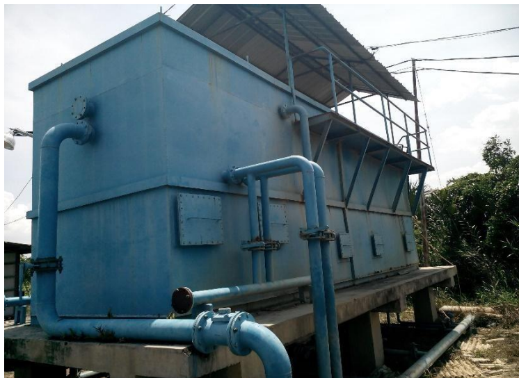
Gambar 3.15 IPA I PTN dengan kapasitas 15L/dt di Cabang II Sungai Tabuk
