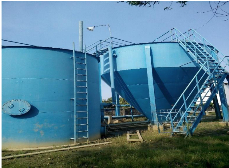
Gambar 3.18 IPA II WKE dengan kapasitas 20L/dt di Cabang II Kertak Hanyar
