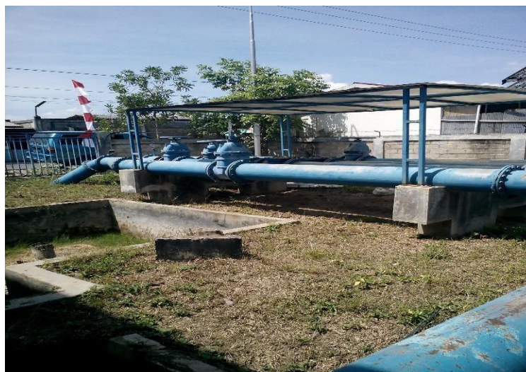
Gambar 3.27 Pipa Distribusi (transmisi) Cabang I Landasan Ulin
