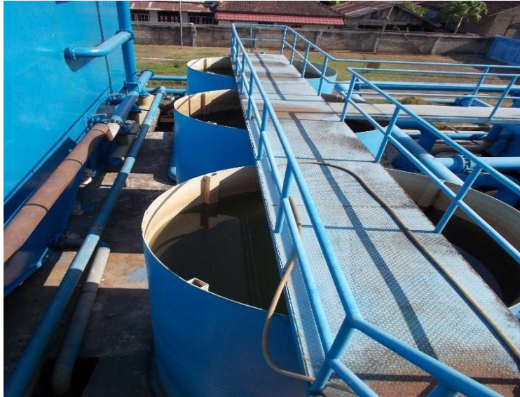
Gambar 3.14 Unit Koagulasi Flokulasi PDAM Intan Banjar
