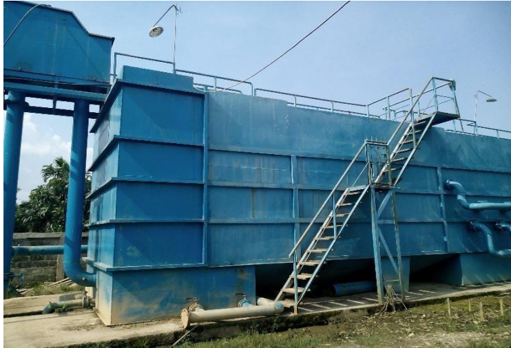
Gambar 3.17 IPA I Ruhak dengan kapasitas 50L/dt di Cabang II Kertak Hanyar
